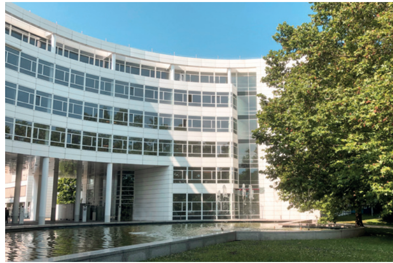
Das neue Dienstgebäude am Dienstsitz München in der St.-Martin-Straße 72.
